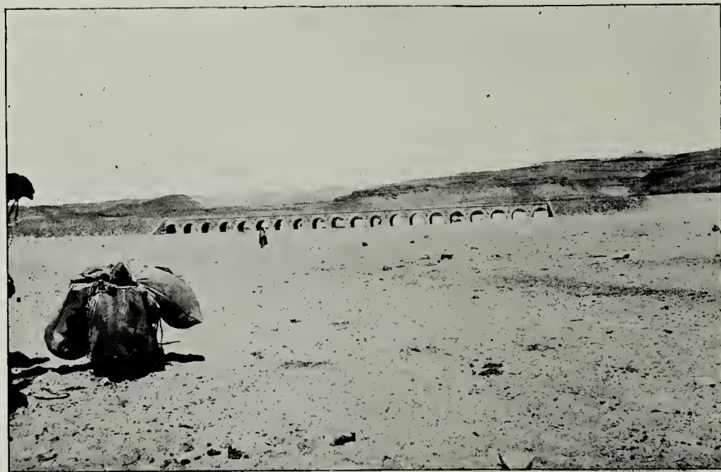
Fig. 56. — Pont du chemin de fer à l'embouchure de l'ouâdy el-Ahḍar.
